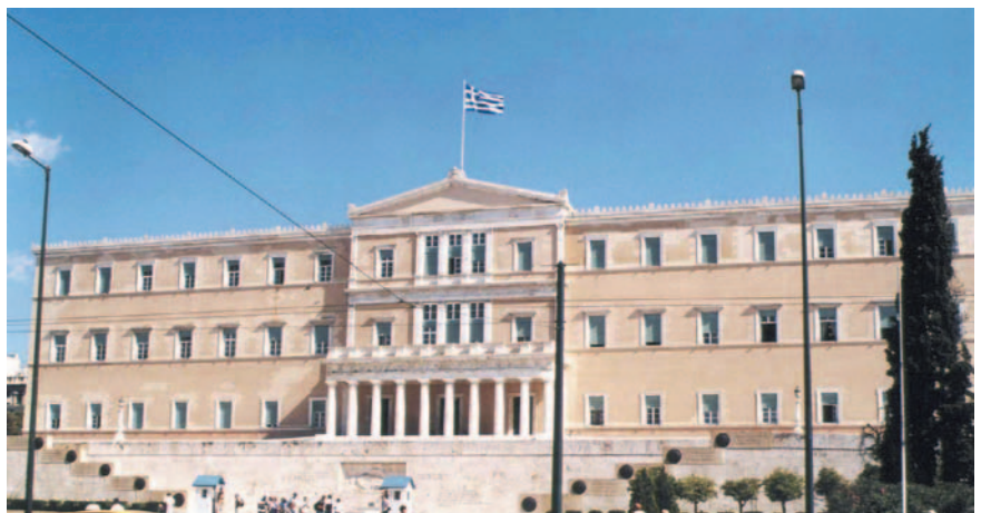
10. Η Βουλή των Ελλήνων , έργο του Φρειδερίκου φον Γκέρτνερ . Το κτίριο σχεδιάστηκε αρχικά ως ανάκτορο του Όθωνα.
