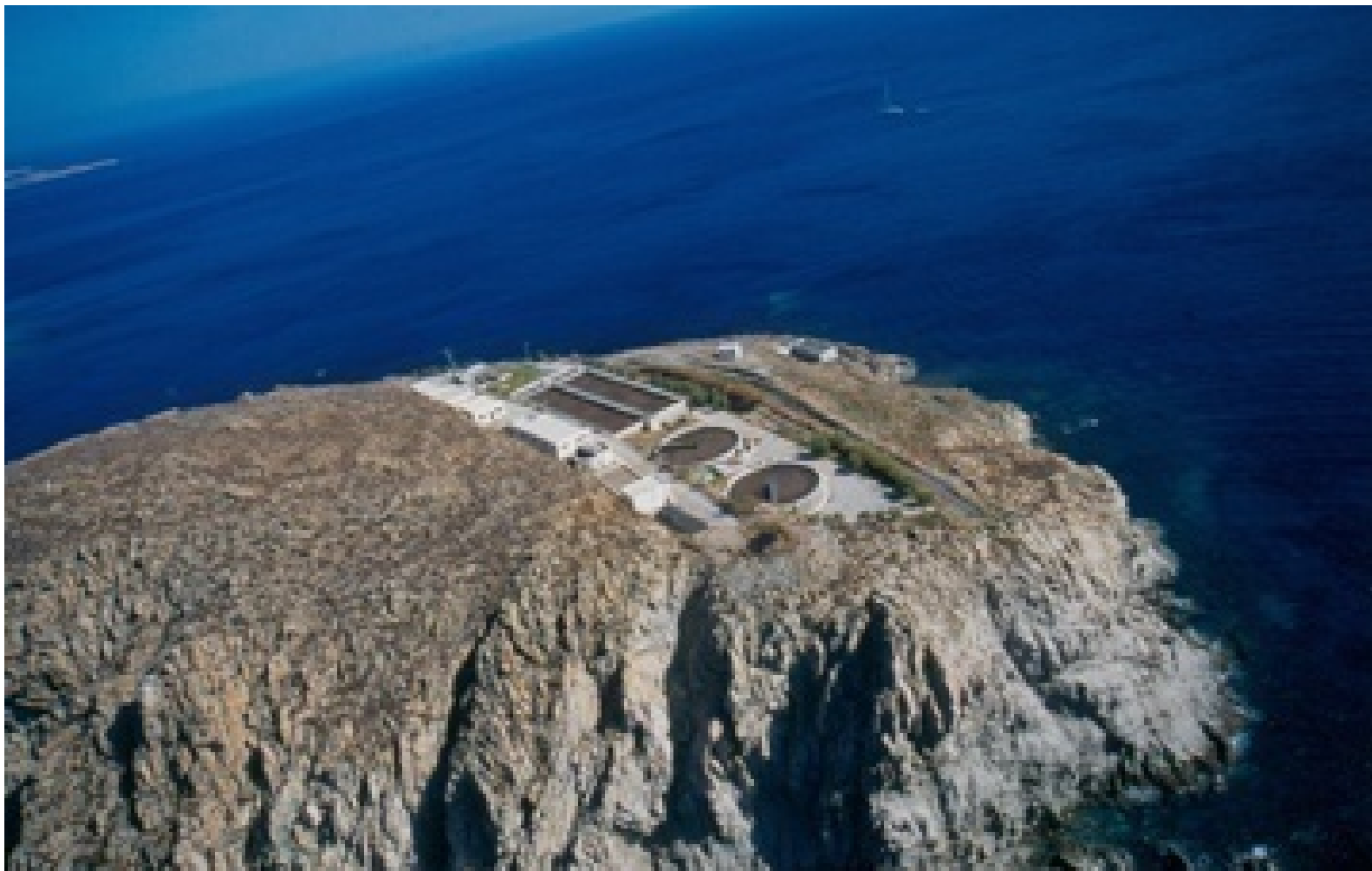
Σχ. 106. Εγκατάσταση Βιολογικού καθαρισμού στη Μύκονο.
