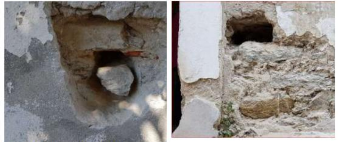
Εικόνα 14- Τυπικές τομές λιθοδομής
