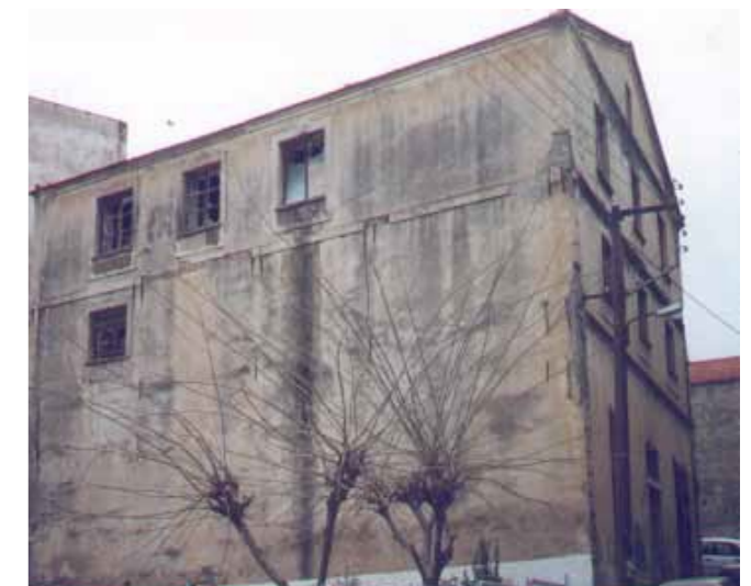
Εγ2. 5 Μονόχωρη με δίριχτη στέγη καπναποθήκη στην Καβάλα.
