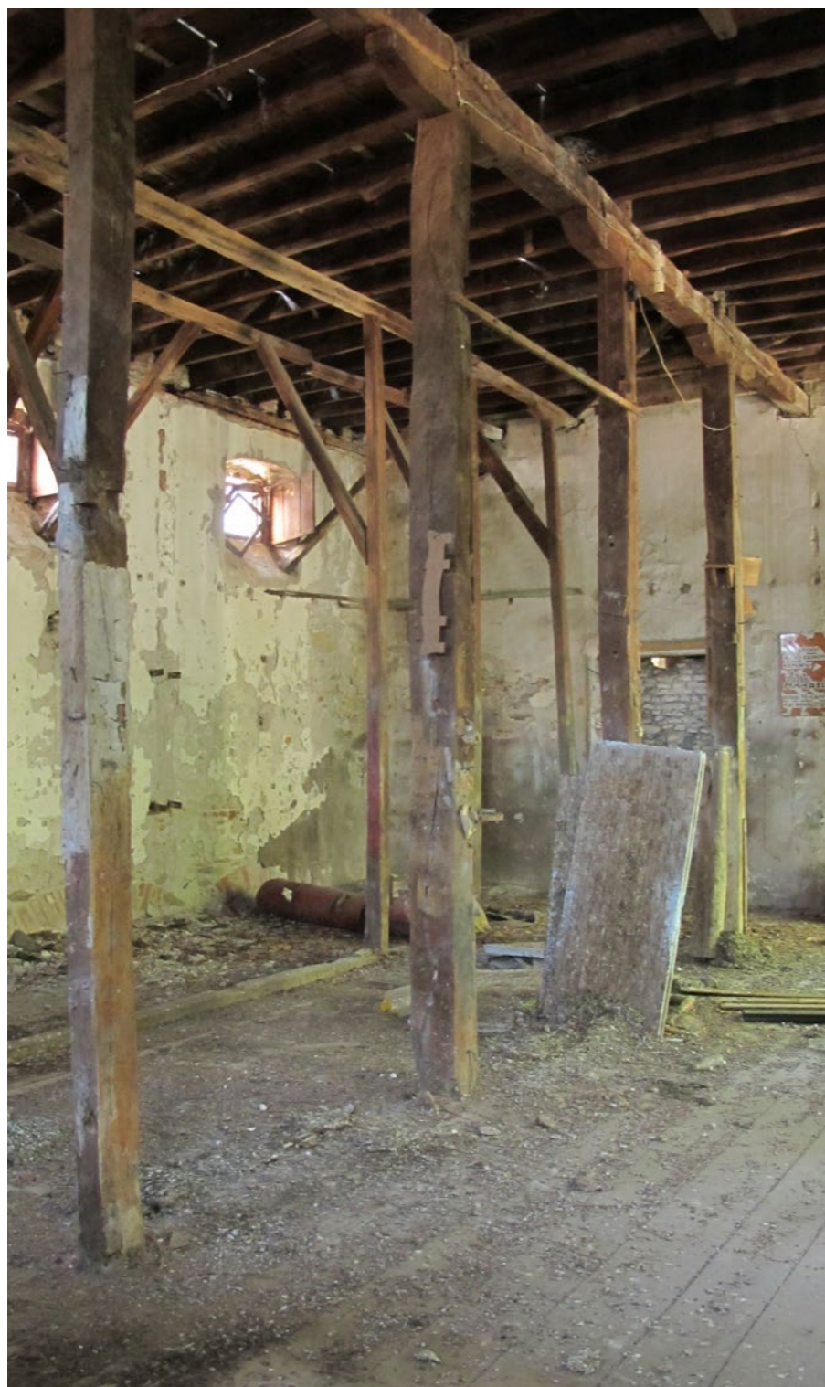
Επι. 19 Ισόγειος χώρος κτηρίου Α. Άποψη προς την νότια όψη.
