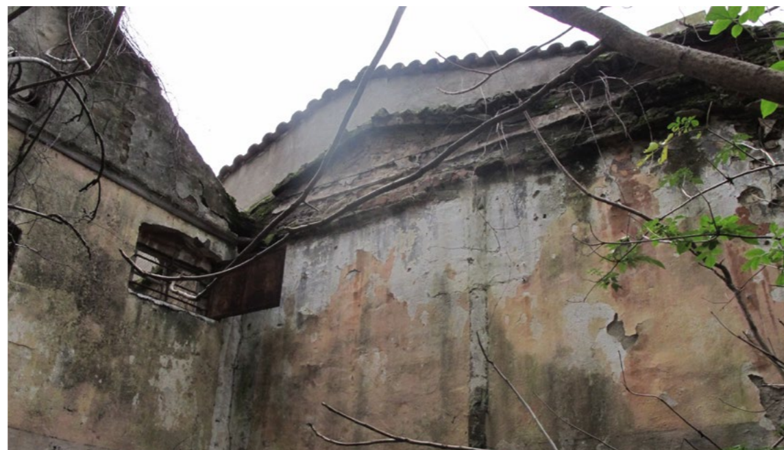
Εγ4. 7 Κατεδαφισμένο κτήριο Γ. Αποχρωματισμοί, αποκόλληση επιχρίσματος και ανερχόμενη από το έδαφος υγρασία.
