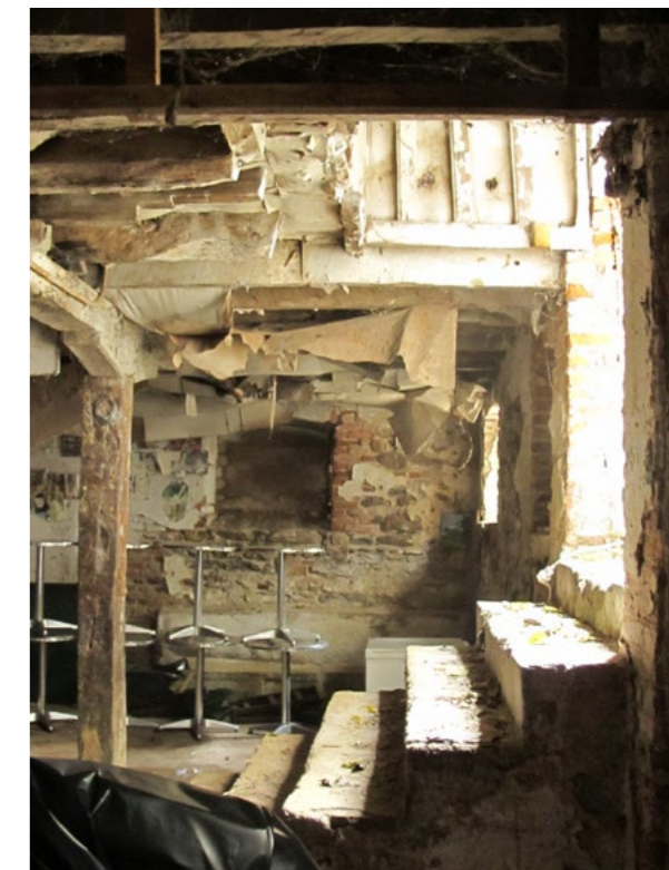
Επ. 17 Σκάλα καθόδου στο υπόγειο Α.
