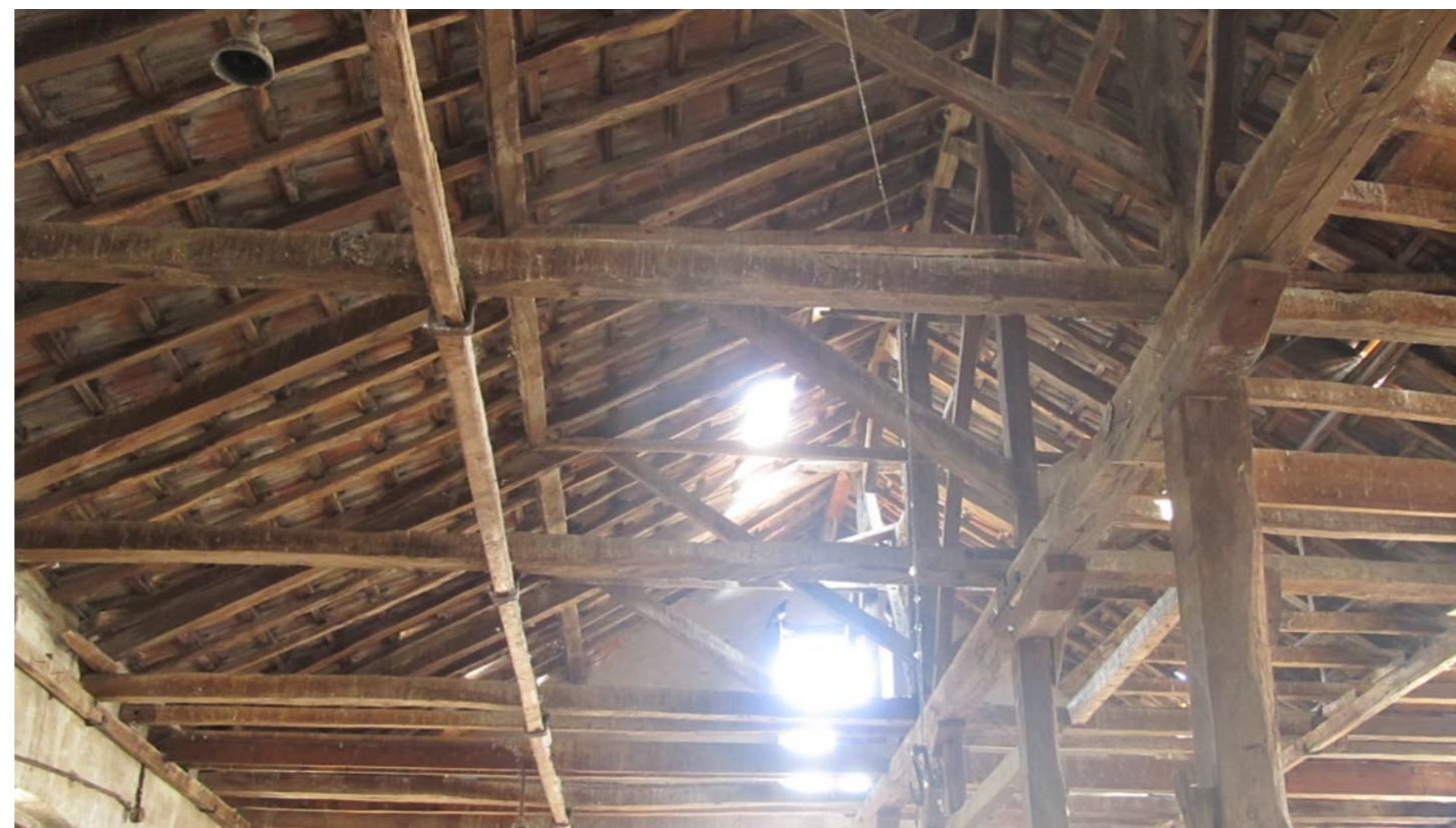
Εγ3. 8 Καθιστή στέγη του κτηρίου Α κατά μήκος του άξονα Βορρά Νότου.
