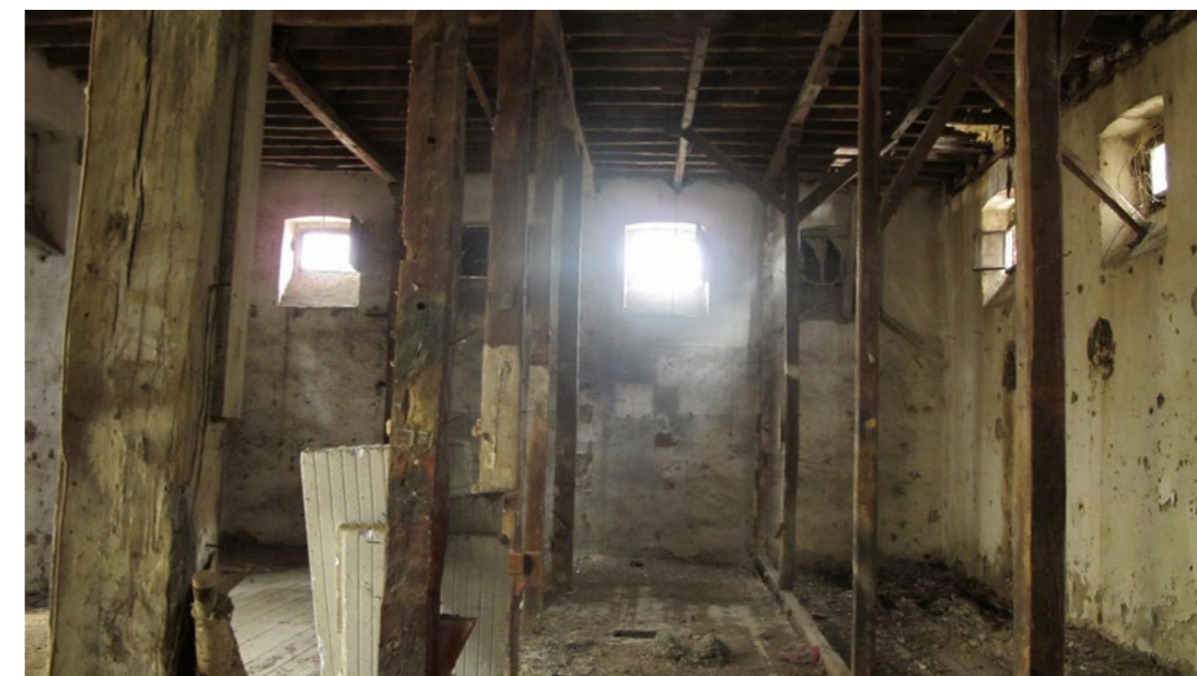
Επι. 21 Ισόγειος χώρος κτηρίου Α. Άποψη προς την βόρεια όψη.
