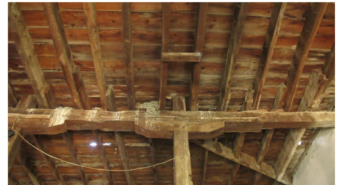
Εγρ. 10 Δάπεδο ορόφου Α κτηρίου όπως φαίνεται από το κάτωθεν ισόγειο. Οι κύριες δοκοί βρίσκονται στον άξονα Βορρά - Νότου. Τα πατόξυλα στον άξονα Ανατολής- Δύσης και οι σανίδες επικάλυψης πάλι στον επιμήκη Βορρά - Νότου.
