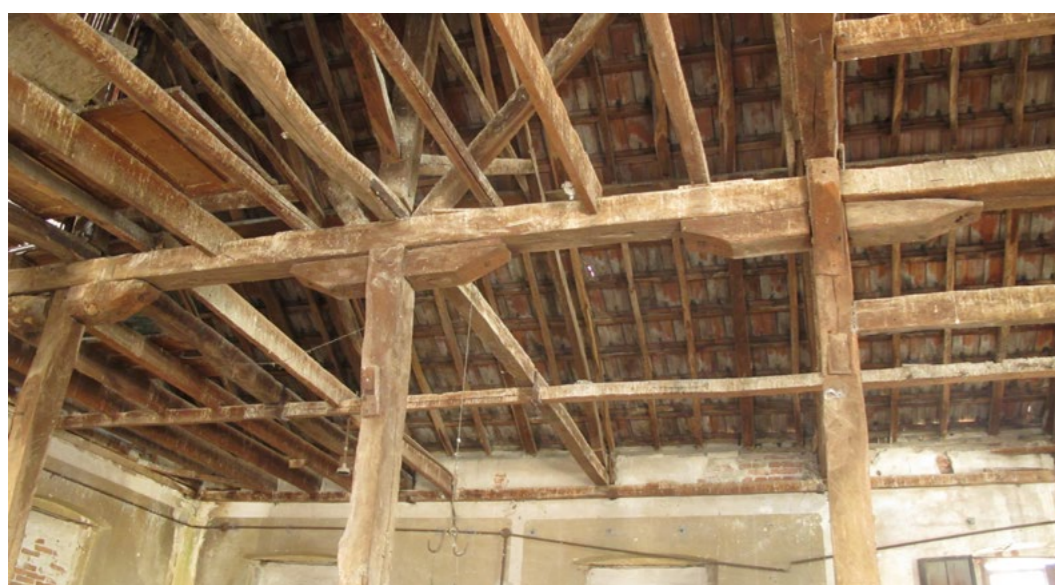
Εγ3. 6 Κρεμαστή στέγη στο κτήριο Β. Έχει καταρρεύσει ολόκληρη σειρά ζευκτών.
