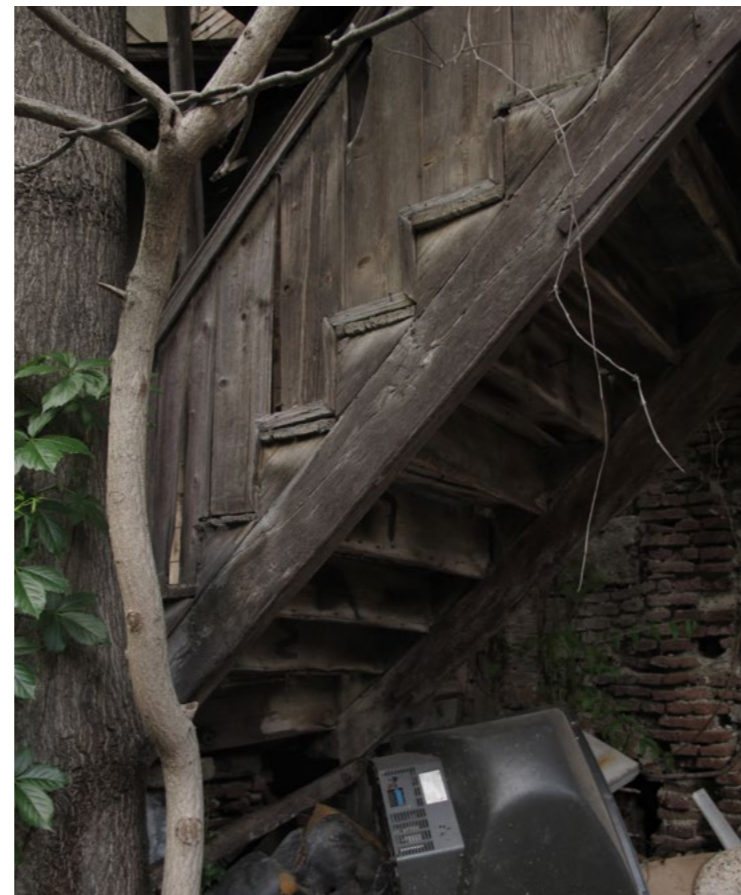
Εγ3. 3 Λεπτομέρεια ξύλινης βαθμιδοφόρου της εξωτερικής σκάλας.
