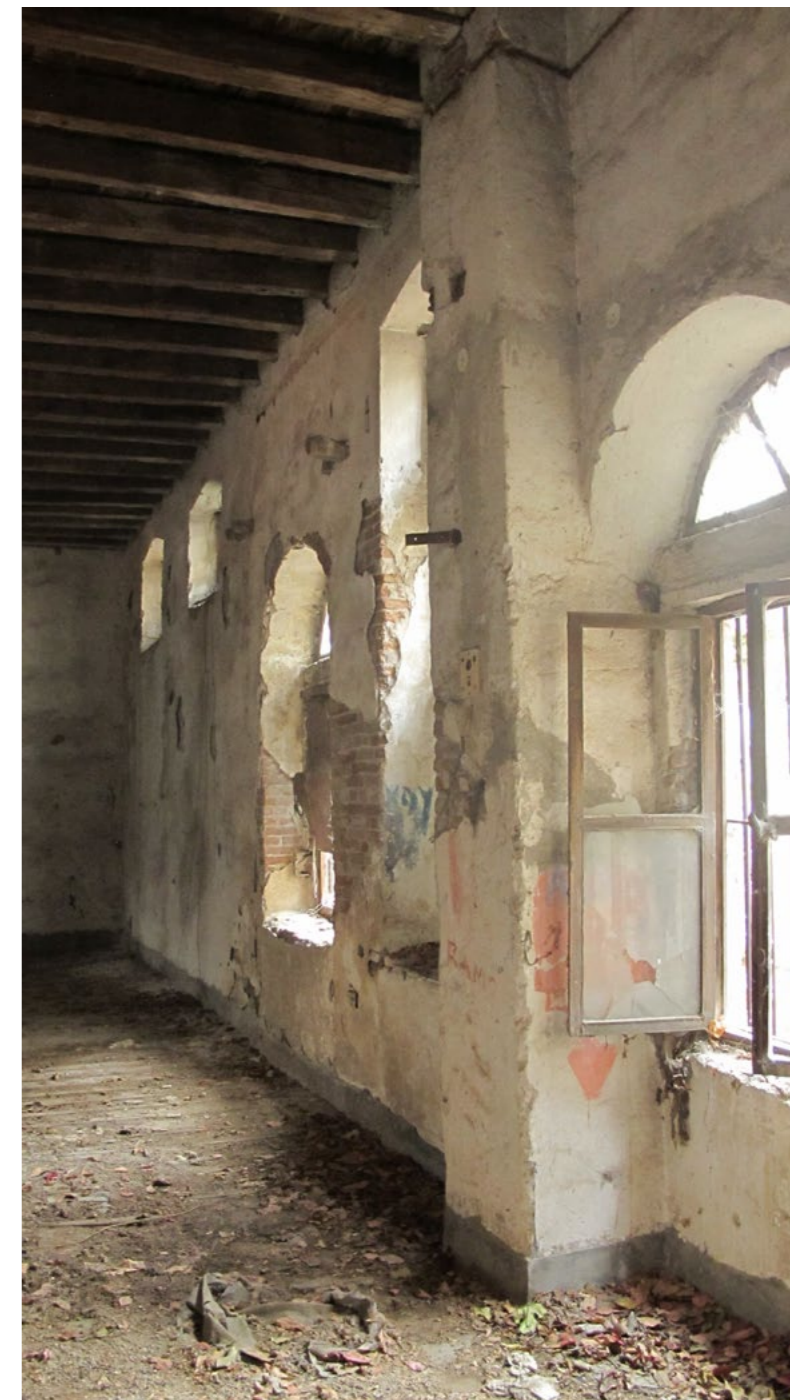
Επι. 27 Ισόγειος χώρος κτηρίου Β. Άποψη προς την δυτική όψη.
