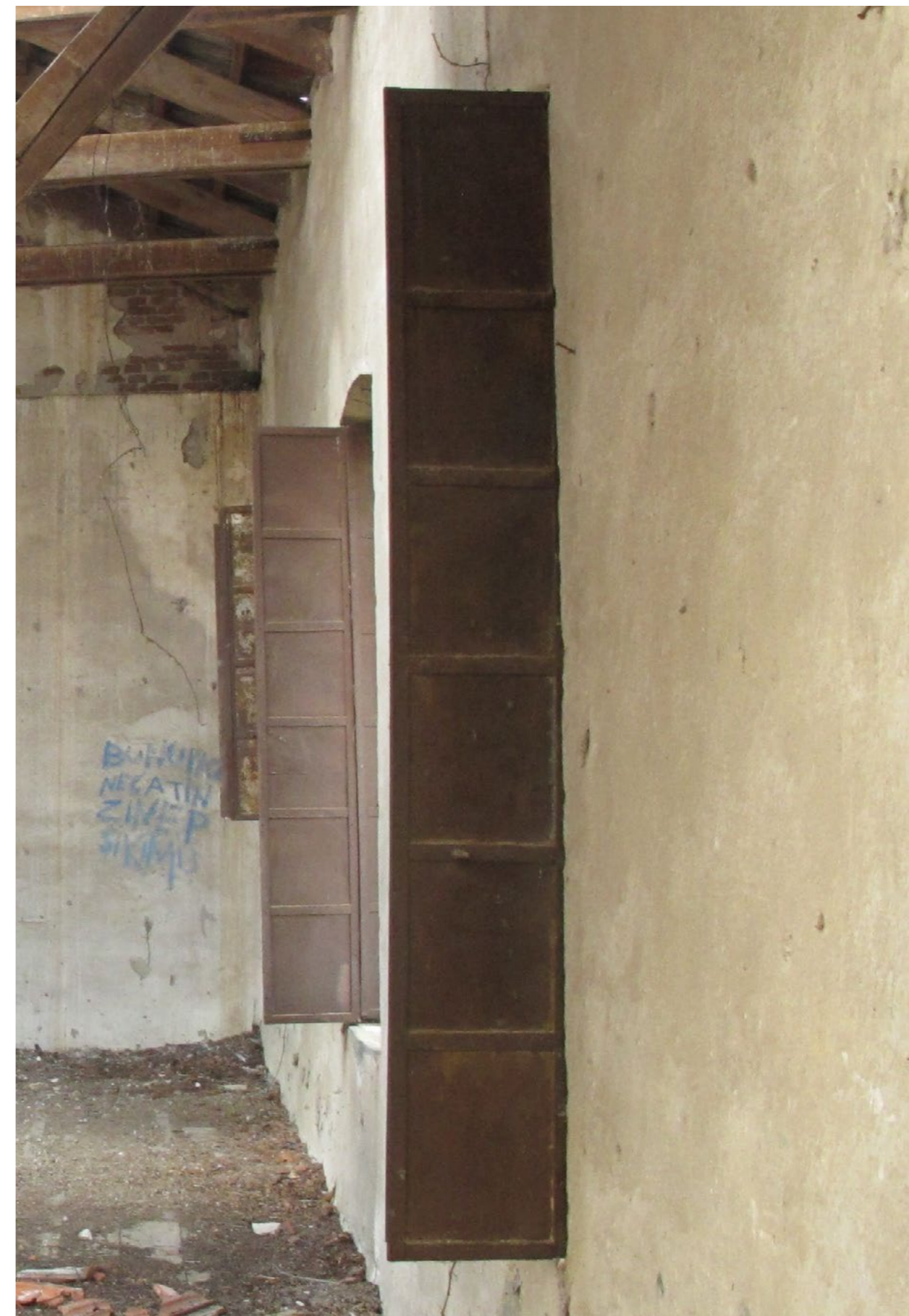
Επ. 31 Μεταλλικά κεπέγκια σκίασης.
