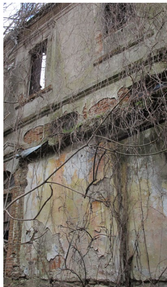
Εγ4. 7 Κατεδαφισμένο κτήριο Γ. Αποχρωματισμοί, αποκόλληση επιχρίσματος και ανερχόμενη από το έδαφος υγρασία.
