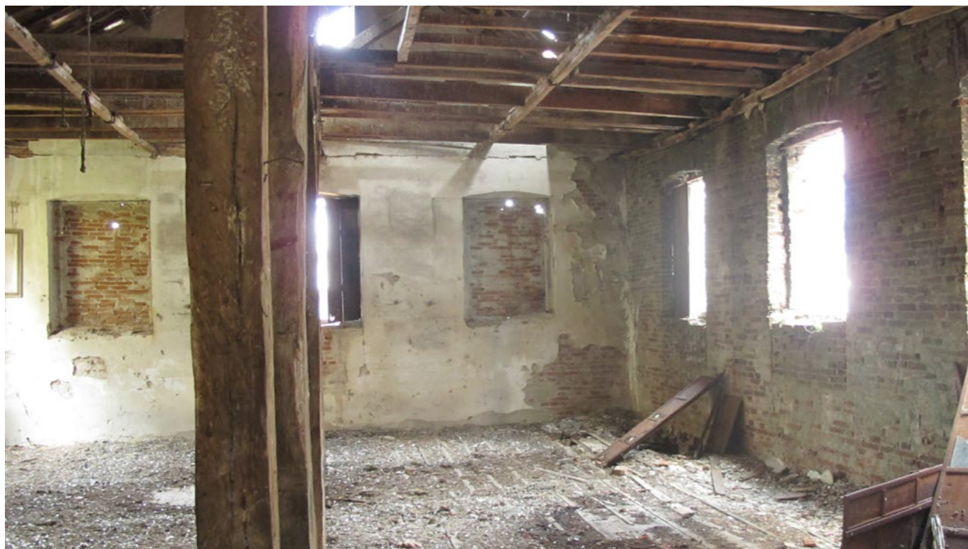
Επ. 29 Όροφος κτηρίου Α. Απόψη προς την βόρεια όψη.
