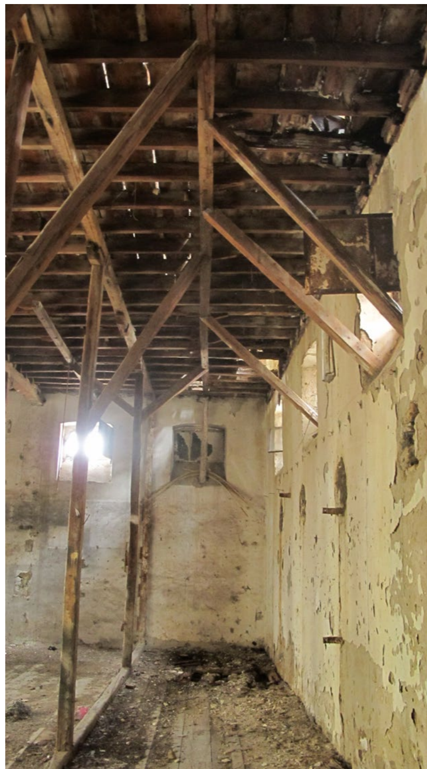
Επι. 20 Ισόγειος χώρος κτηρίου Α. Άποψη προς την βόρεια όψη.
