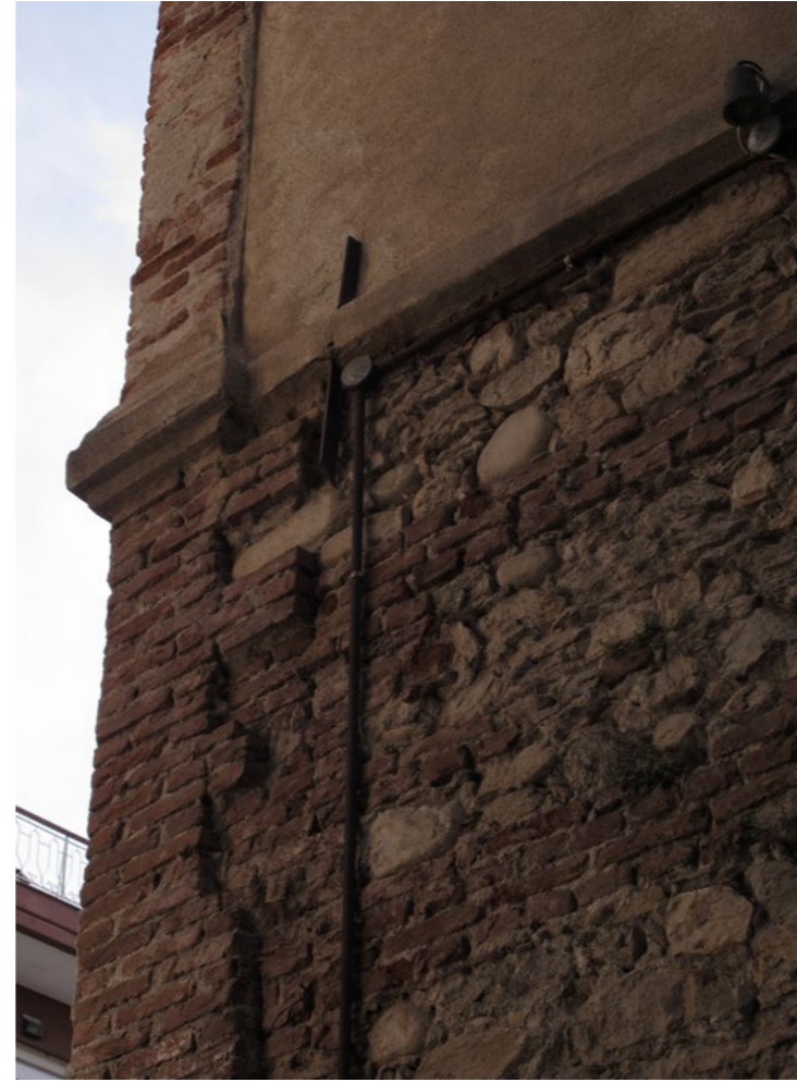
Εγ2. 12 Διακοσμητική ψευτοπαραστάδα. Ανατολική όψη κτηρίου Β.
