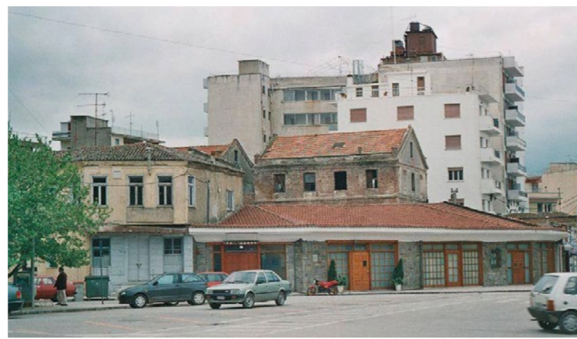
Εβ2. 5 Ανατολική άποψη της ήδη εγκαταλελημένης καπναποθήκης Ζωΐδη στην ΣΤ. οικοδομική φάση τέλη δεκαετία '80.
