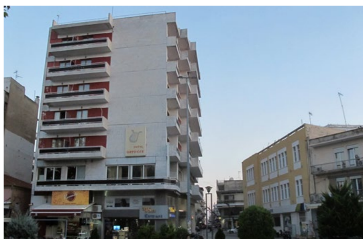
ΕΑ2. 10 Το Ξενοδοχείο Ορφέα, υπερμεγέθες, κρύβει την θέαση του βιομηχανικού μνημείου από την ανατολική πλευρά του αδόμητου χώρου.
