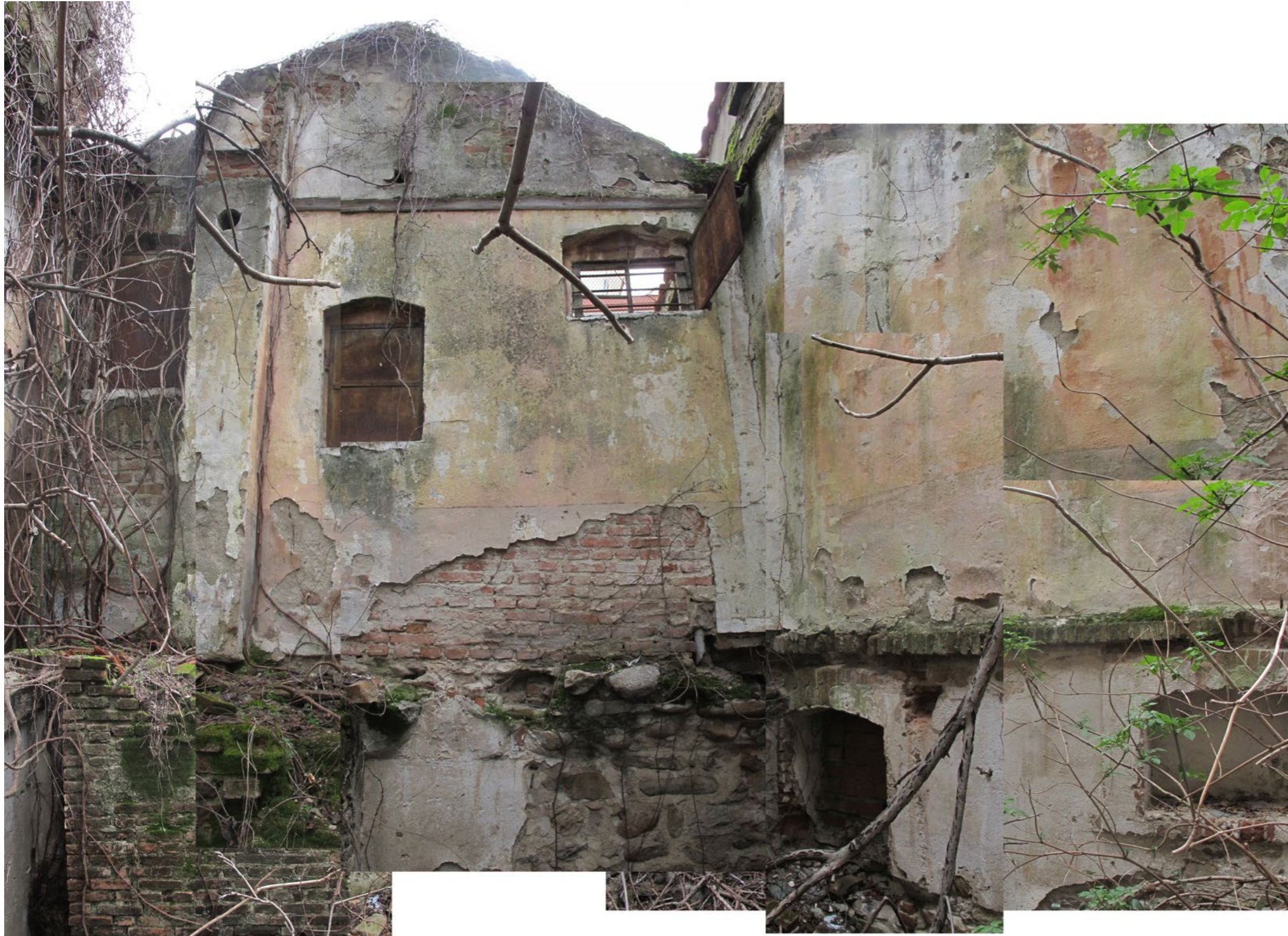
Επ. 28 Κτήριο Γ, εσωτερική όψη στην εσωτερική αυλή.
