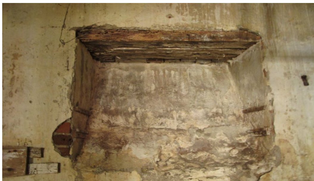
Επ. 16 Παραθύρα υπογείου στην ανατολική όψη του κτηρίου.
