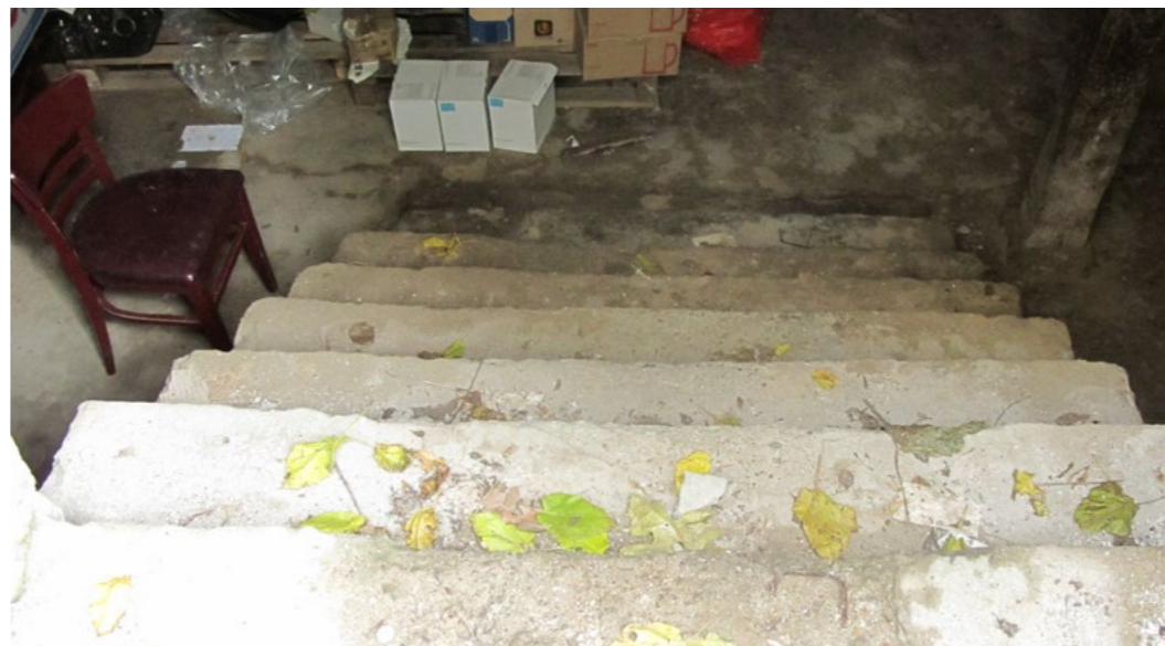
Επ. 14 Λίθινη σκάλα καθόδου στον υπόγειο χώρο.
