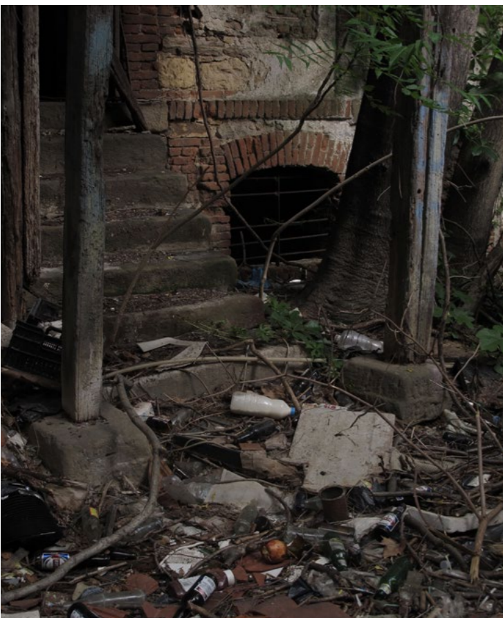
Εγ3. 2 Λίθινες βάσεις ξύλινων υποστυλωμάτων εξωτερικής σκάλας.
