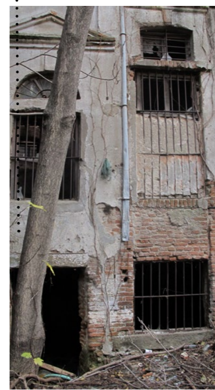
Επι. 11 Εξωτερική ανεξάρτητη είσοδος υπογείου κτήριο Β.
