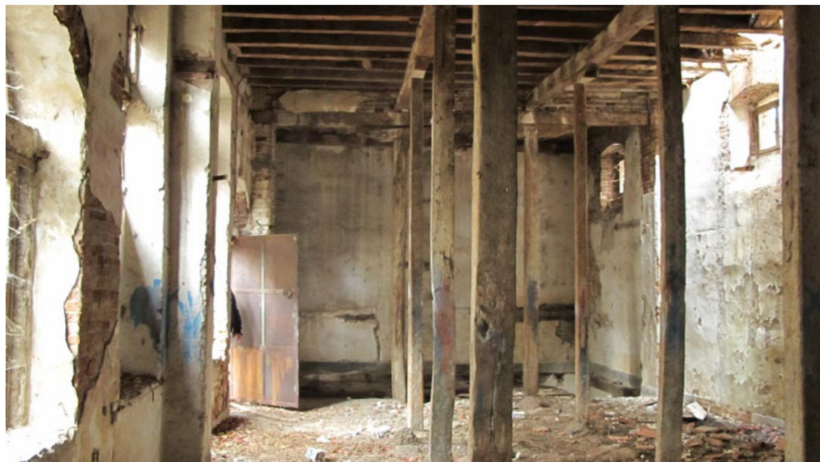
Επι. 24 Ισόγειος χώρος κτηρίου Β. Άποψη προς την βόρεια όψη.
