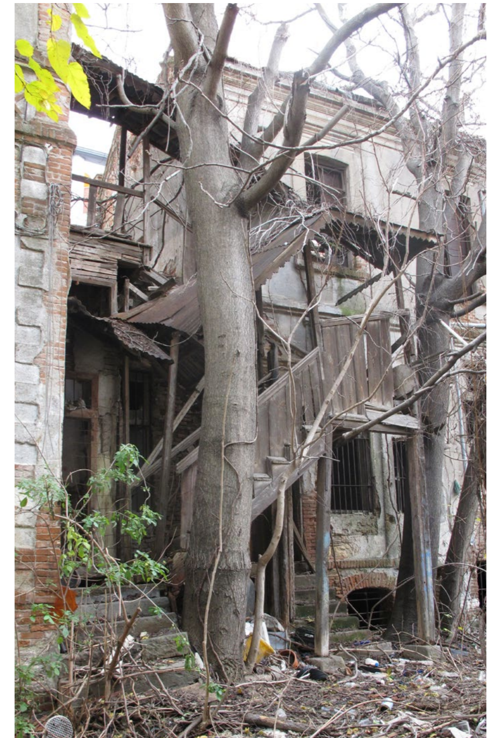
Επι. 12 Εξωτερική ξύλινο κλιμακοστάσιο ανόδου στο επίπεδο των ορόφων για τα κτήρια Α &amp; Β.
