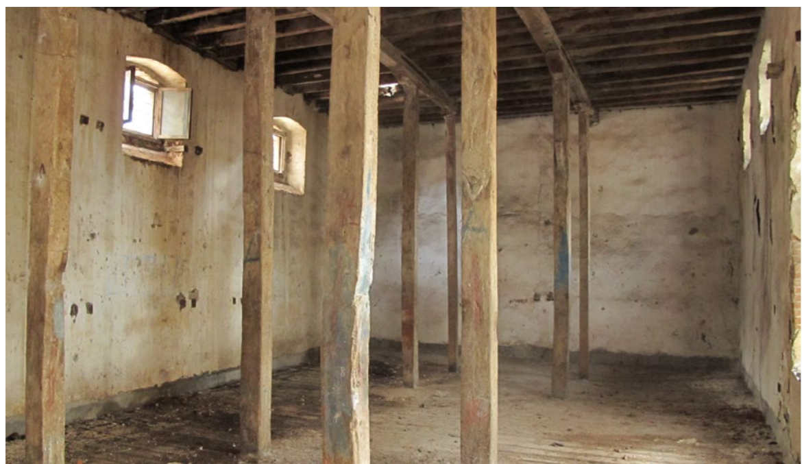
Επι. 25 Ισόγειος χώρος κτηρίου Β. Άποψη προς την νότια όψη.
