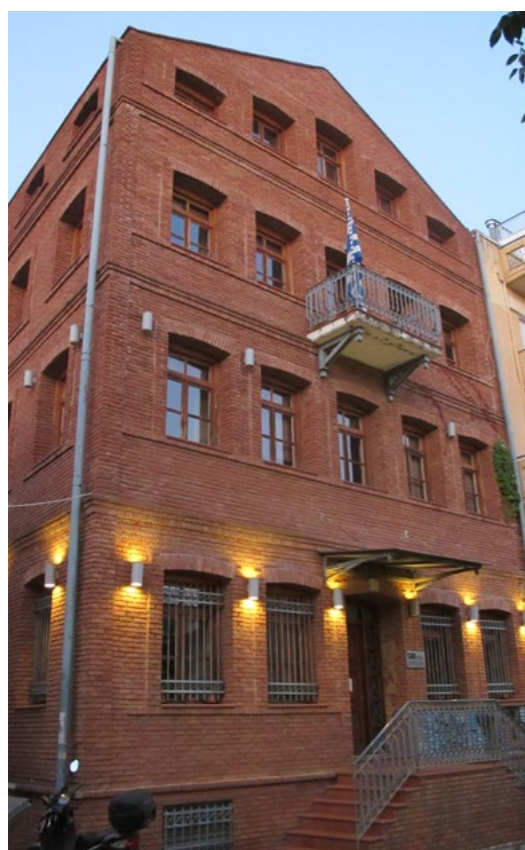
ΕΑ1. 49 Το κτήριο του ΤΕΕ. ή αλλιώς η καπναποθήκη της οδού Παρνασσού.
