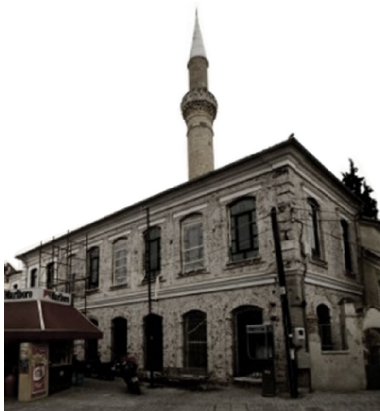
Εאי. 8 Γενί Τζαμί, άποψη του μνημείου πριν την αποκατάσταση στις αρχές του 2000. Το μνημείο βρίσκεται εντός του πρώτου Οθωμανικού κέντρου στην παλιά αγορά.
