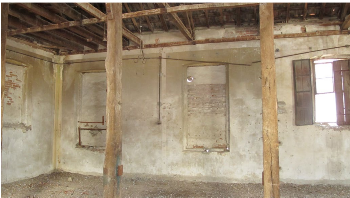
Επ. 30 Όροφος κτηρίου Α. Απόψη προς την δυτική όψη.
