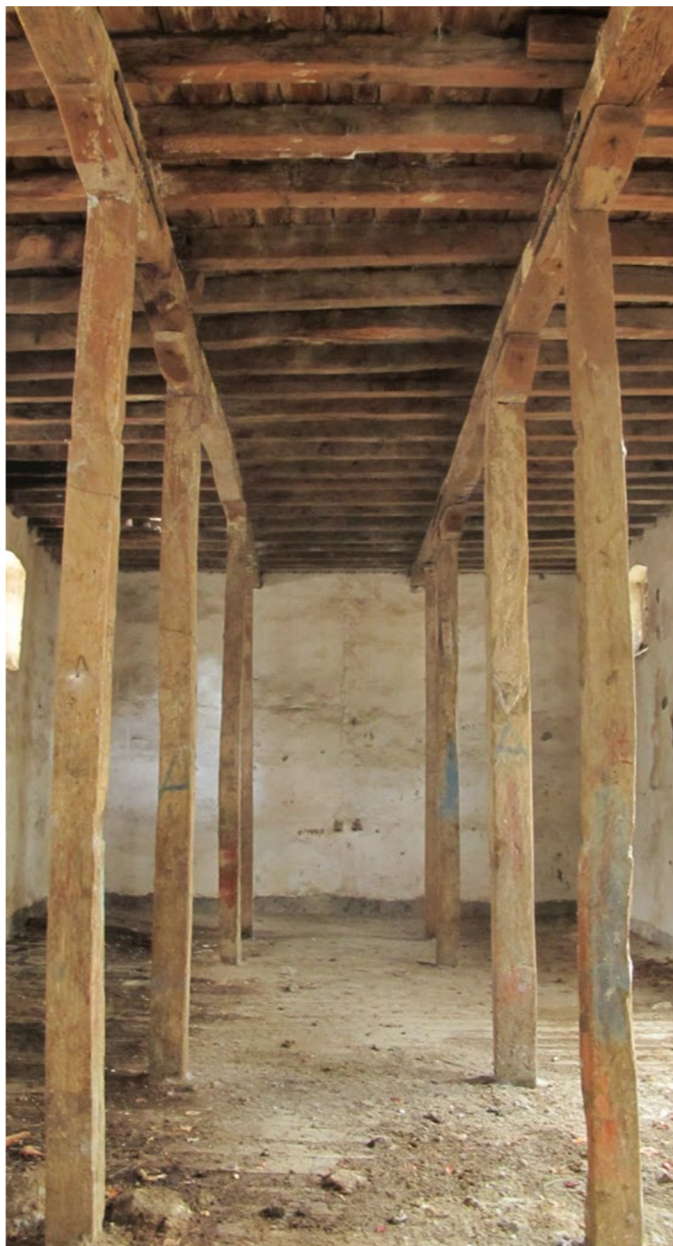
Επι. 26 Ισόγειος χώρος κτηρίου Β. Φέρουσες γραμμές ξύλινων υποστυλωμάτων.
