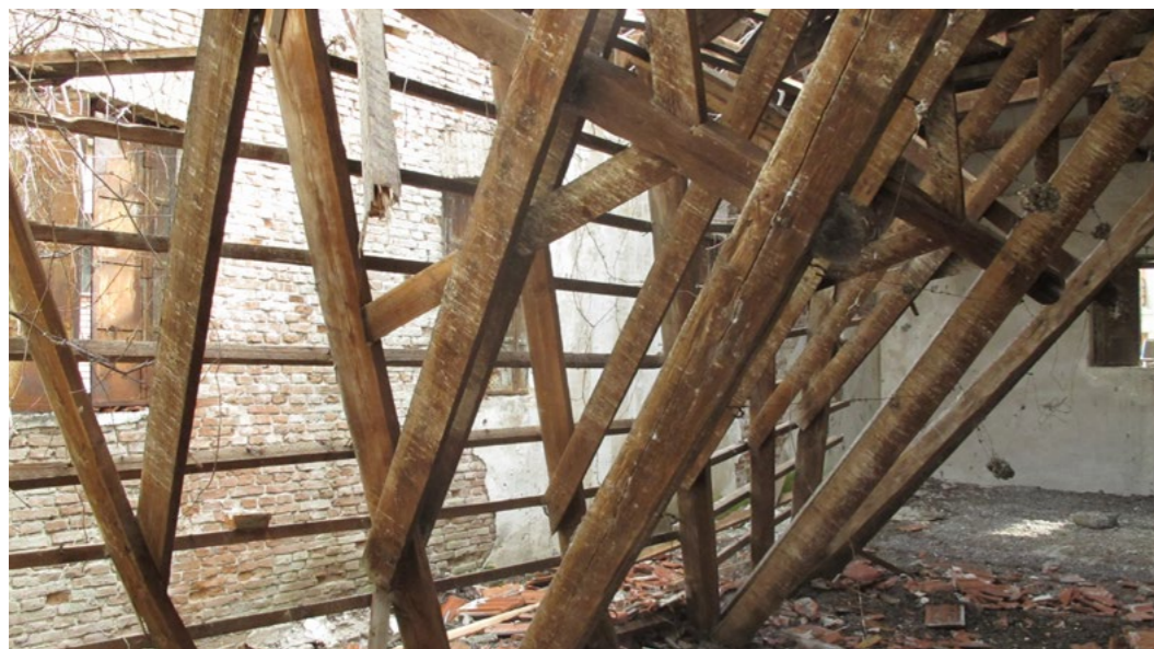
Εγ3. 6 Κρεμαστή στέγη στο κτήριο Β. Έχει καταρρεύσει ολόκληρη σειρά ζευκτών.
