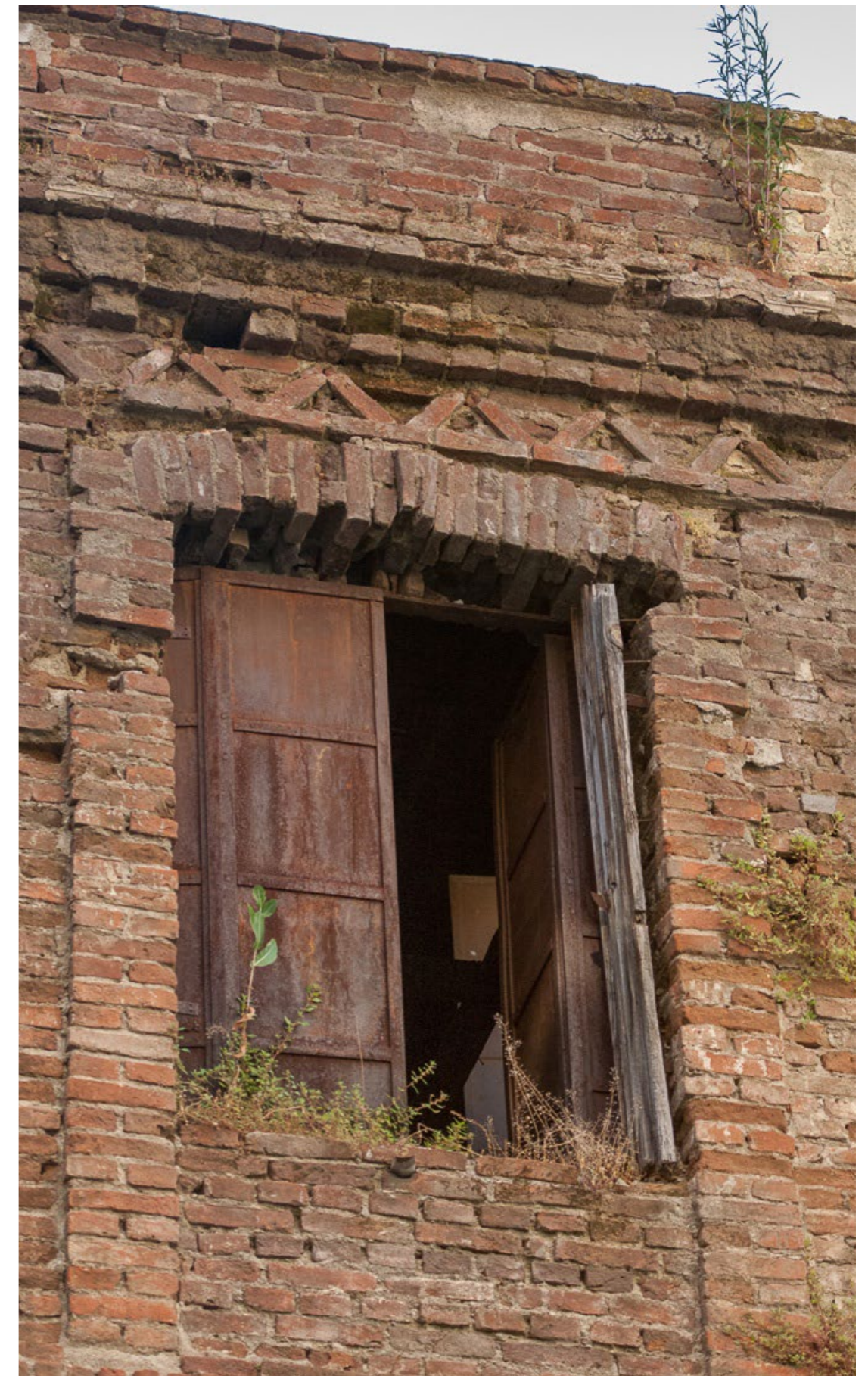
Εγ2. 14 Λεπτομέρεια ανοίγματος Ορόφου. Κτήριο Α, Ανατολική όψη.
