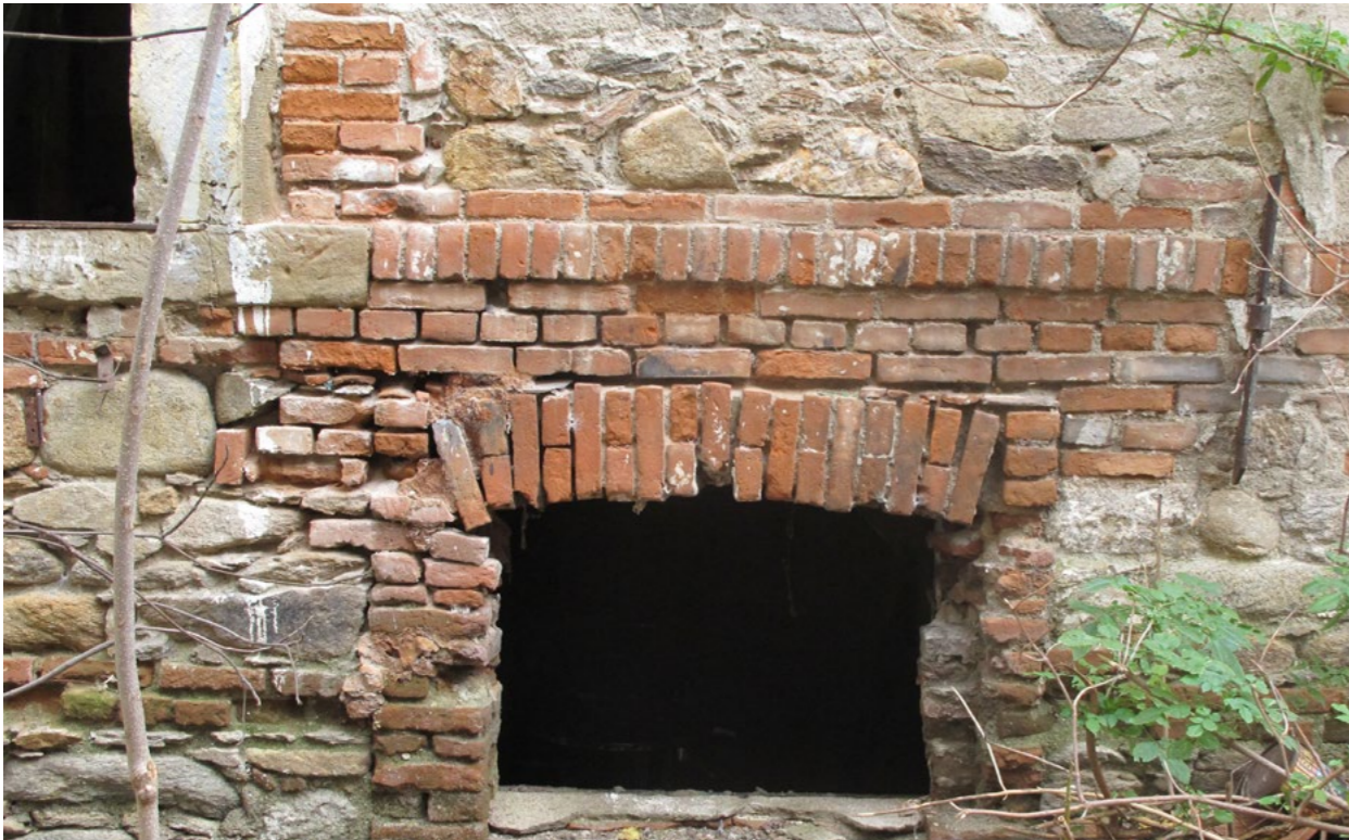
Εγ3. 1 Μικτή λιθοδομή στην βάση του υπογείου, προγενέστερο κτήριο Α.
