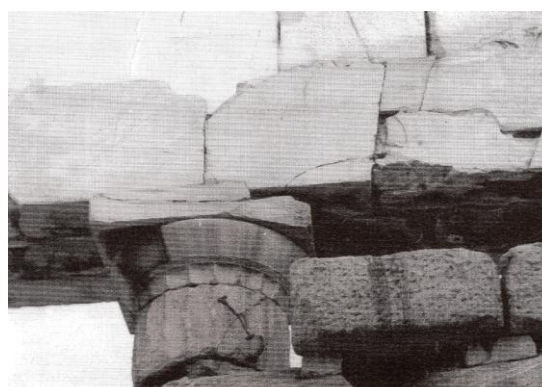
Εικόνα 11. Σύνδεσμος διπλού T, για τη στερέωση ενός ρηγματωμένου σφονδύλου κίονα του Παρθενώνα. 1
