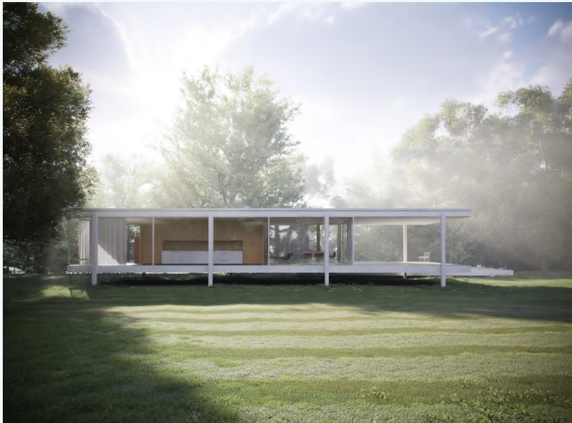
Farnsworth House – L. Mies Van der Rohe
