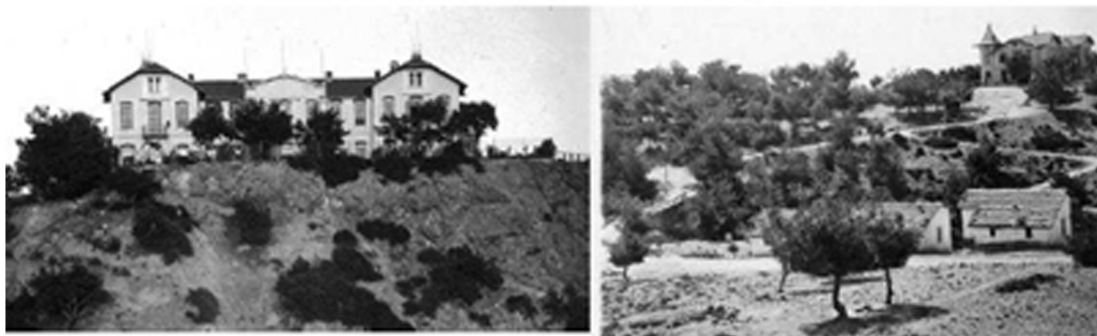
Γενικές απόψεις του κτιρίου κατοικίας -διοίκησης της επιχείρησης Spreidel, των εργατικών κατοικιών και της μεταλλικής γέφυρας (1916). (Πηγή: ΓΑΚ Νομού Καβάλας).
