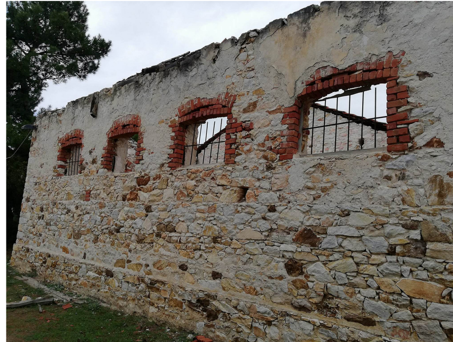
Άποψη τμήματος του κτηρίου - Νοτιοδυτική όψη Διακρίνουμε την φέρουσα τοιχοποιία και το σύστημα κατασκευής της.
