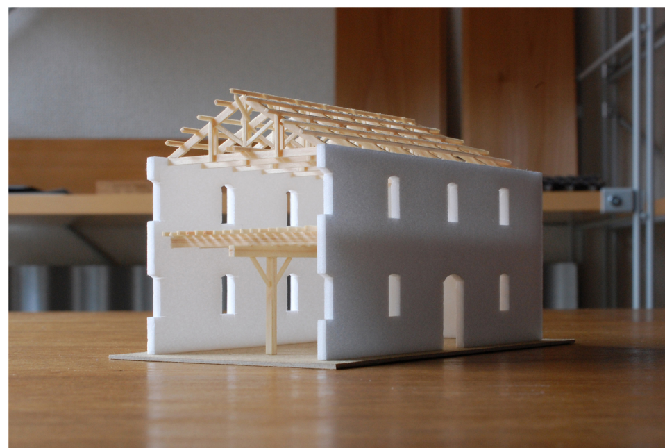
Μακέτα αποκατάστασης. Διακρίνεται ο σκελετός της στέγης και η τυπολογία των ανοιγμάτων.
