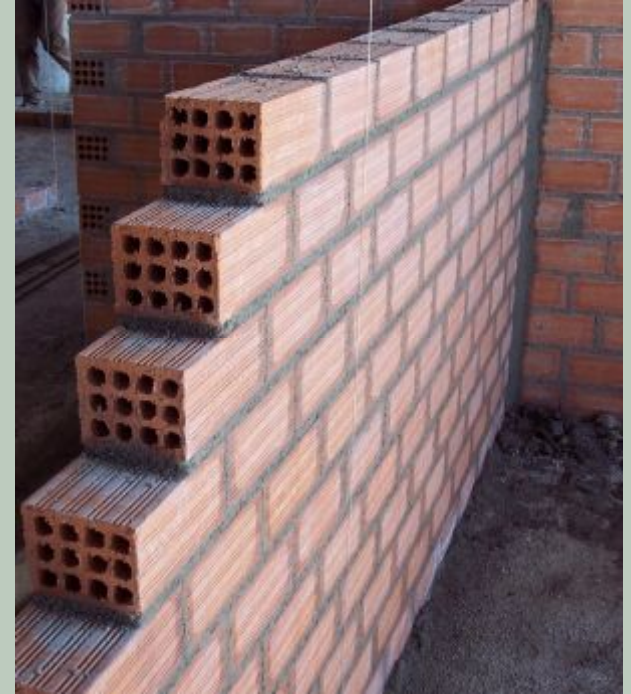
Δρομική τοιχοποιία από δωδεκάοπα τούβλα (πηγή: e-oikodomos.blogspot.com)
