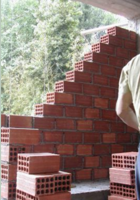
Τοποθέτηση τούβλων κατά το κλιμακωτό χτίσιμο.
