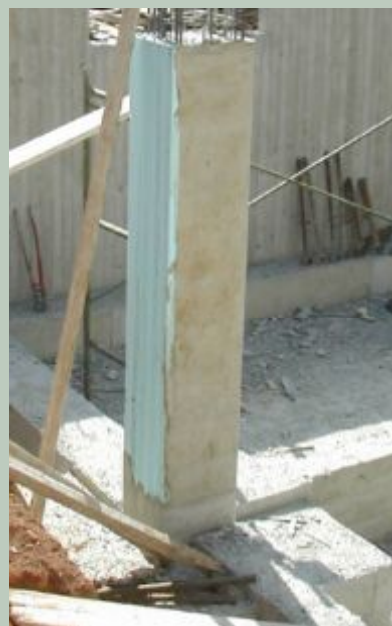
Θερμομόνωση στην εξωτερική επιφάνεια του υποστυλώματος μετά το ξεκαλούπωμα.
