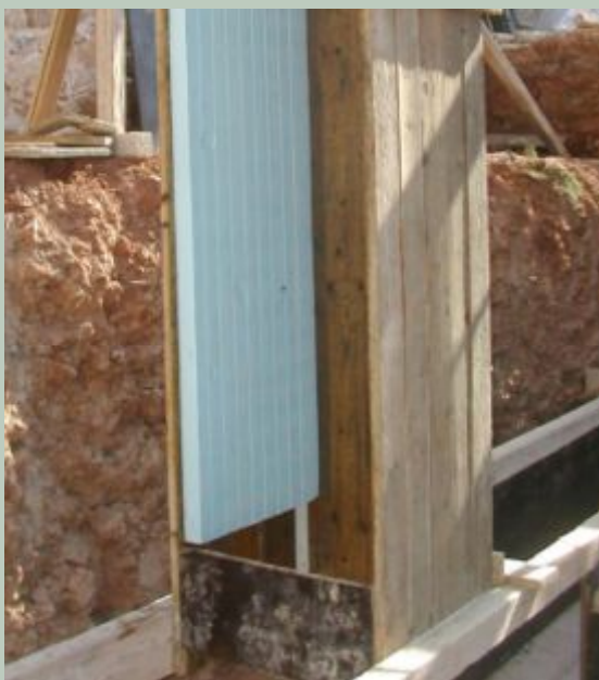
Τοποθέτηση θερμομόνωσης σε καλούπι υποστυλώματος πριν τη σκυροδέτηση.
