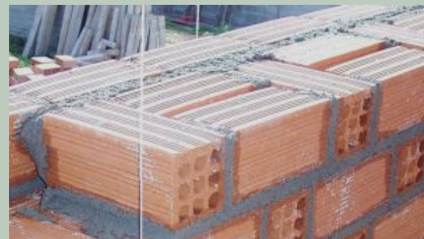
Υπερμπατική τοιχοποιία από εννιάοπα τούβλα
