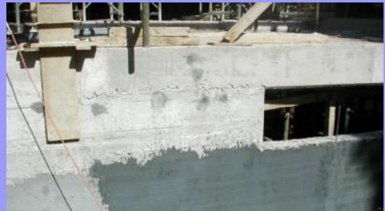
Επάλειψη τοιχώματος υπογείου με τσιμεντοκονίαμα.
