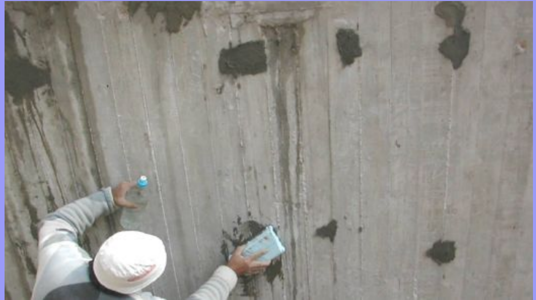
Εφαρμογή τσιμεντοειδούς επισκευαστικού, μη συρρικνούμενου κονιάματος.
