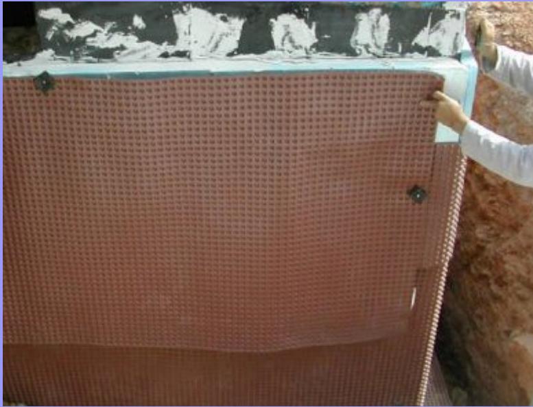
Τοποθέτηση αποστραγγιστικού φύλλου πολυαιθυλενίου (αυγουλιέρας). (πηγή: http://www.arch.ntua.gr/sites/default/files/resource/7846_/06_katotero_patoma.pdf )
