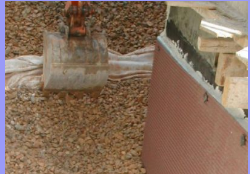
Γέμισμα εκσκαφής με αδρανή υλικά. (πηγή: http://www.arch.ntua.gr/sites/default/files/resource/7846_/06_katotero_patoma.pdf )
