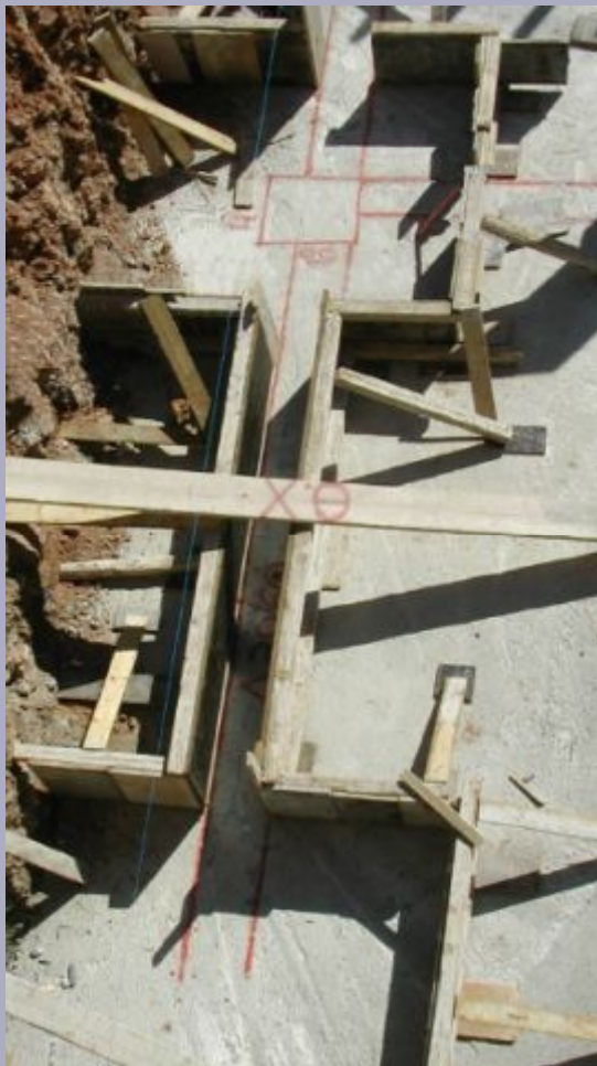
Στήσιμο καλουπιών θεμελίωσης.
