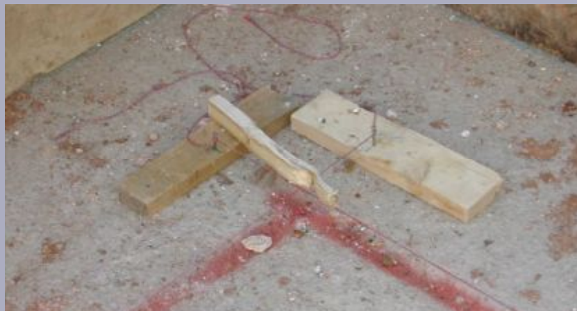
Σχεδιασμός σταθερού σημείου στο μπετόν καθαριότητας.
