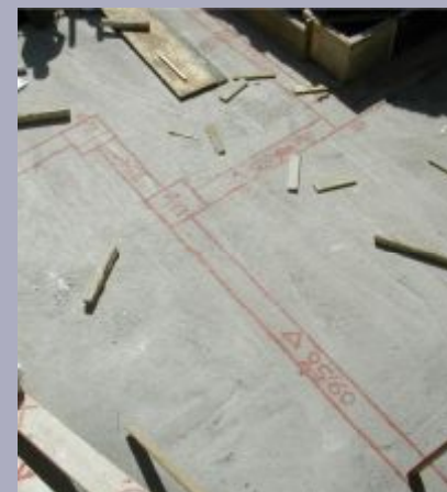
Σχεδιασμός των βασικών στοιχείων της κάτοψης θεμελίων στο μπετόν καθαριότητας.
