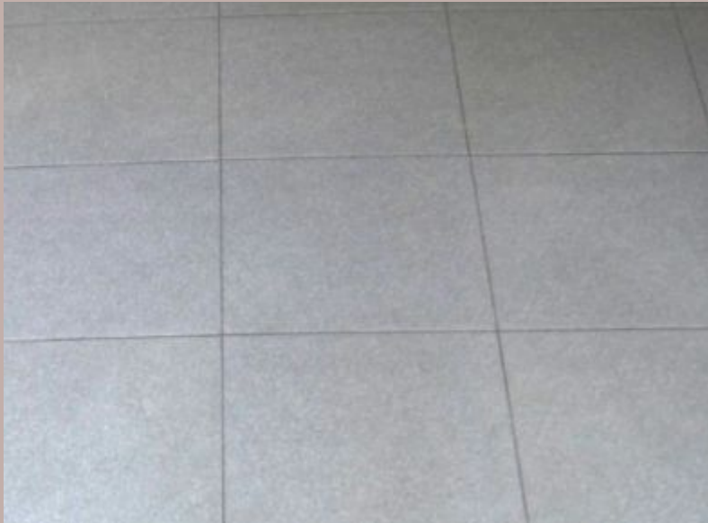
Δάπεδο από κεραμικά πλακίδια.
