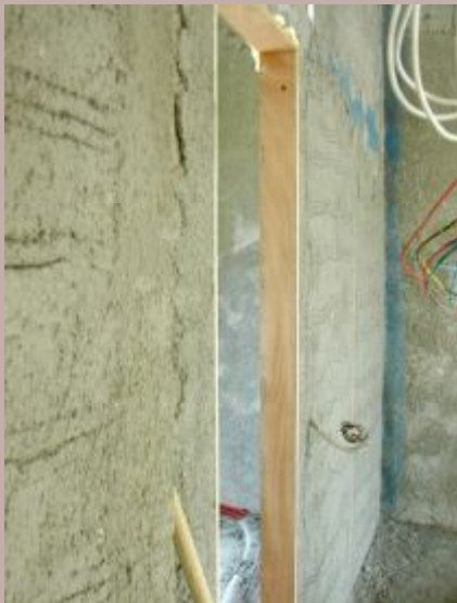
Η ψευτόκασα λειτουργεί ως όριο σοβατίσματος.
