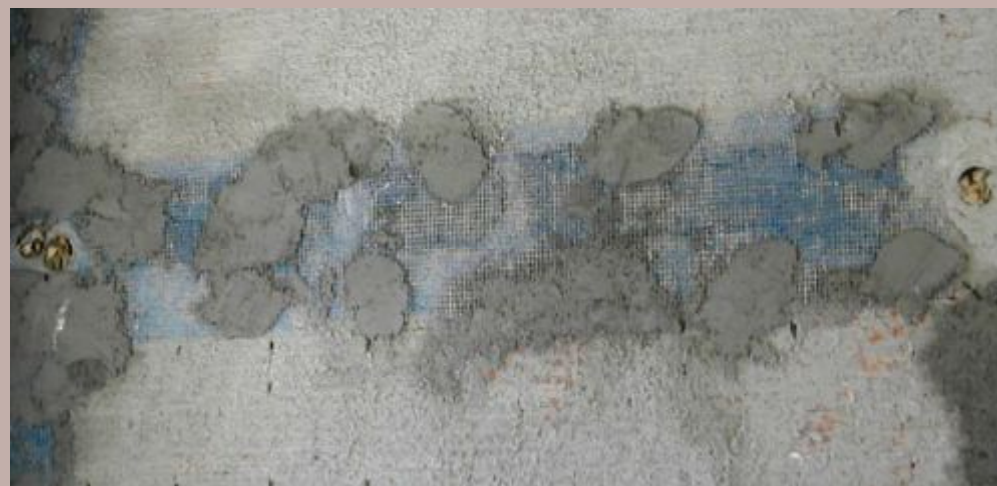
Επικάλυψη 'τραυματισμένης' τοιχοποιίας με πλαστικό πλέγμα.
