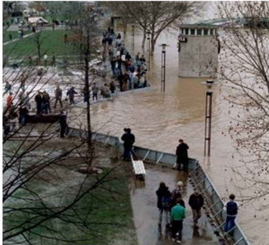
Κατασκευή προστατευτικών τοιχίων
