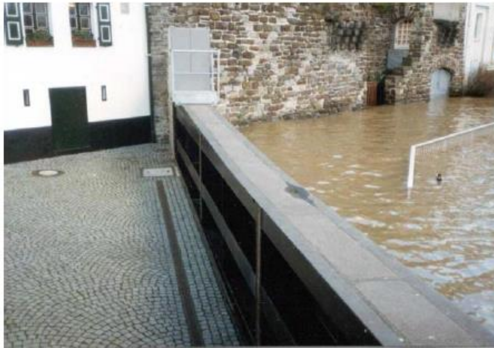
Κατασκευαστικά μέτρα Θυροφράγματα για πλημμυρικά νερά
